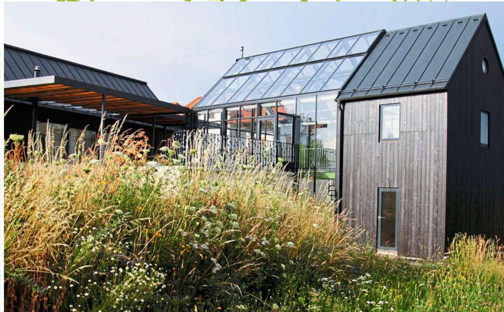
Die „Fernery“ von außen. Das acht Meter hohe Glashaus mit 40 m² Grundfläche wird im Winter mit lokal produzierter Fernwärme geheizt
